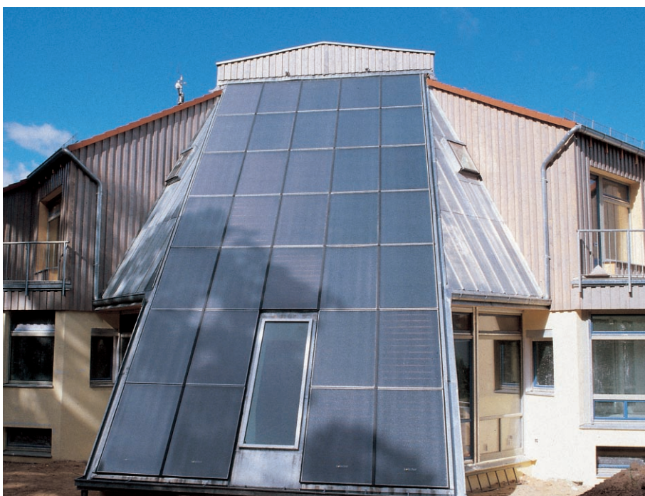
Bild 49 „Null“-Heizenergiehaus mit Ziegeln, Berlin-Spandau.
