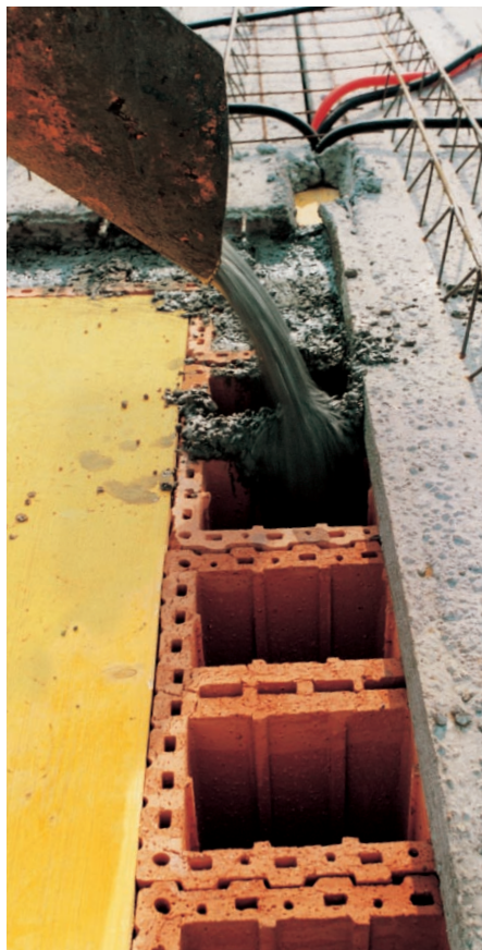
Bild 12 Schallschutz-Füllziegel.
